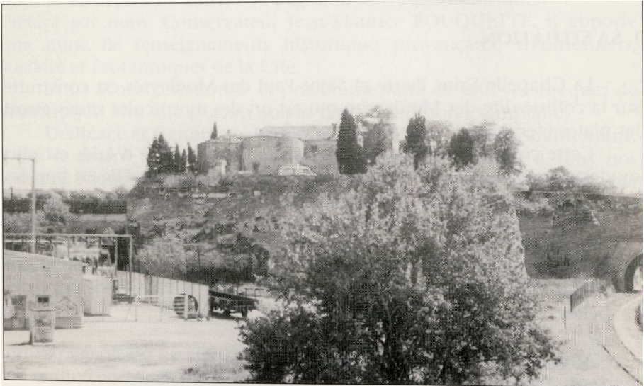
Saint Pierre des Mouleyrès - Côté nord Rocher entre la bifurcation des voies ferrées
